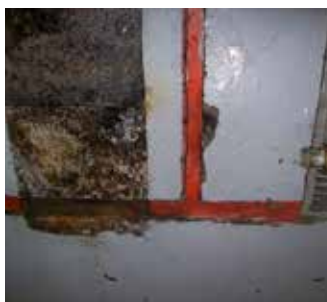
Junta deteriorada
