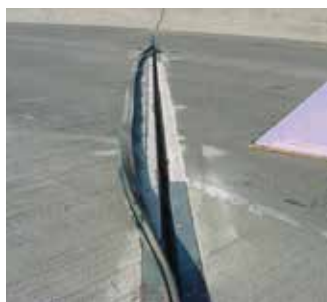
Junta danificada
