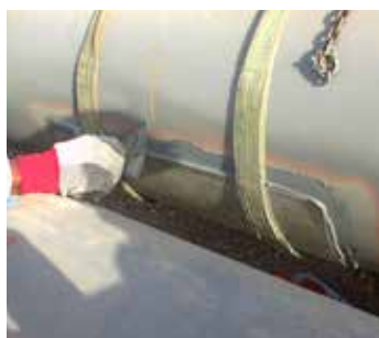
Colagem e enchimento
