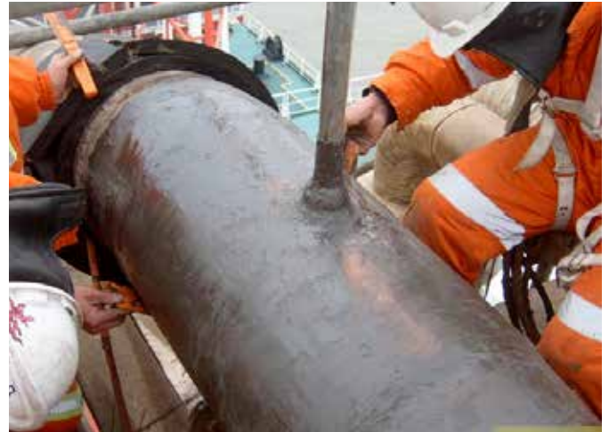
Reparo em tubulações de petróleo e água quente
