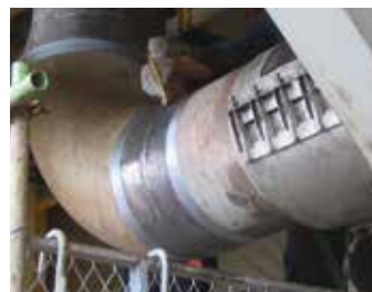
Reparo de soldas
