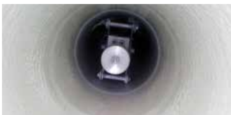
Antes, durante e depois de uma aplicação de Belzona 1381, por pulverização, no interior de tubulações
