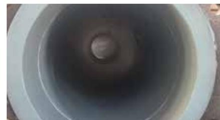
As cores claras de Belzona 1523 permitem fácil inspeção visual nos vasos.
