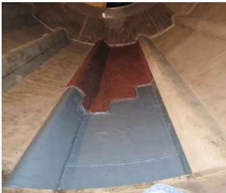
Belzona 1811 (Ceramic Carbide) é um revestimento bicomponente, para reparo e proteção de superfícies sujeitas a ataque abrasivo.
