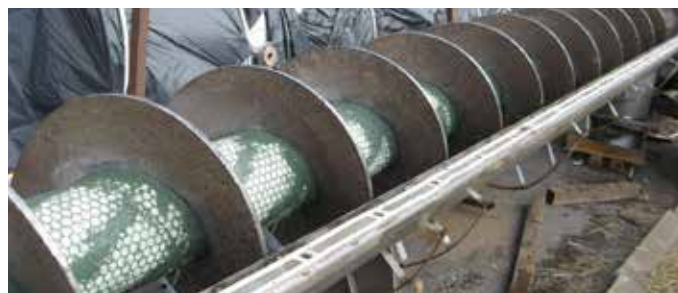
O transportador helicoidal reparado com Belzona 1813 e ladrilhos de alumina
