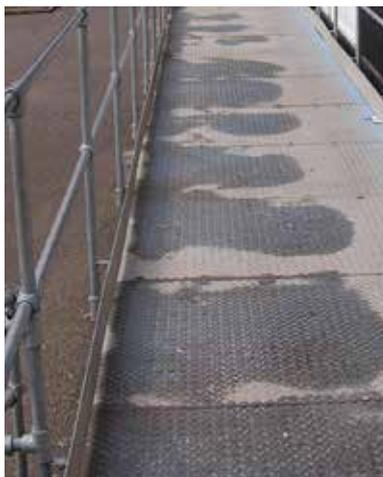
Rampa de aço desgastada antes do revestimento
