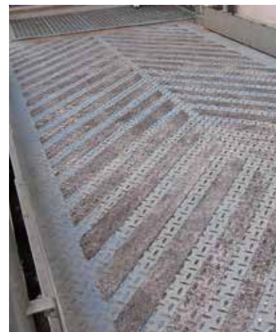
Rampa com juntas em V feitas com Belzona 1821
