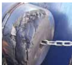
Peça danificada restaurada
