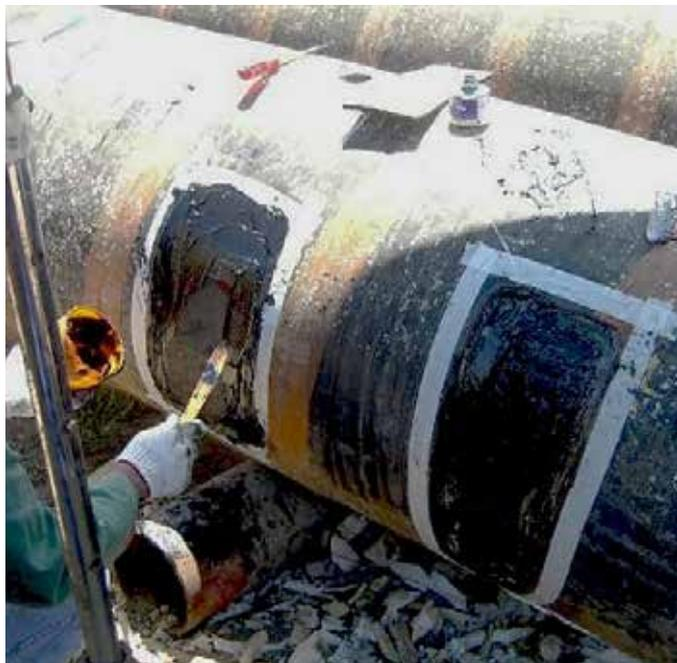
Belzona 2311 (SR Elastomer) é um compósito polimérico e elastomérico bicomponente para reparo e restauração de componentes de borracha.
