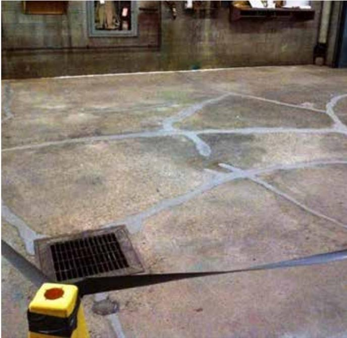
Rachadura reparada com sistemas Belzona 4151 e 4111
