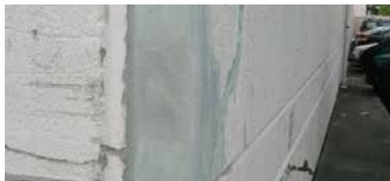
Belzona 4151 foi injetado antes que as rachaduras fossem preenchidas com Belzona 4111
