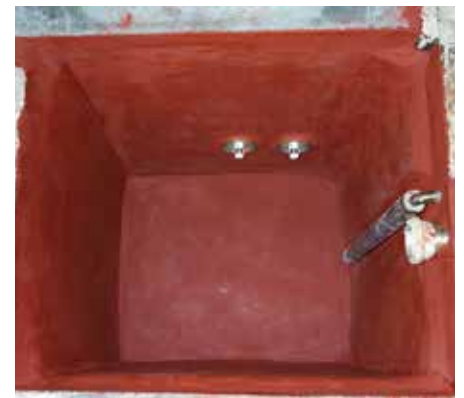
Reservatório após revestido
