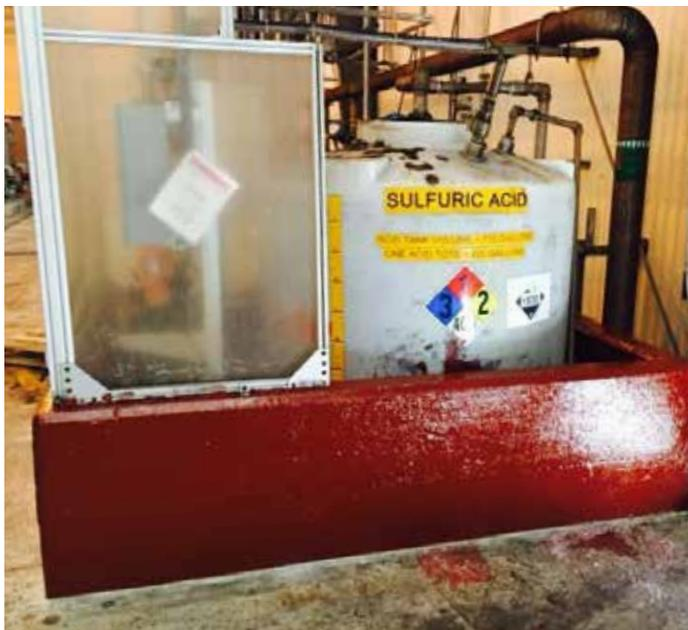
Belzona 4361 é um revestimento de barreira flexível para proteção de áreas de contenção química.
