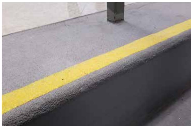
Detalhe de Belzona 4411 após mais de um ano em uso
