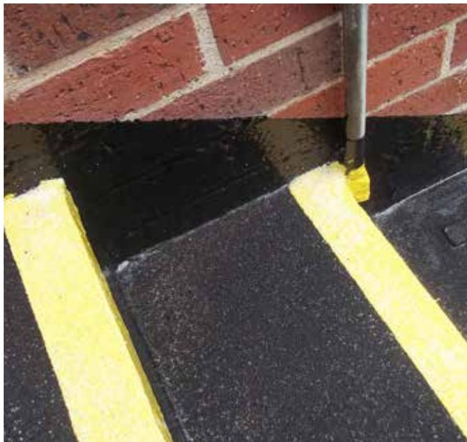
Belzona 4411 (Granogrip) é um sistema de segurança antiderrapante, que cria uma superfície durável resistente a escorregões.
