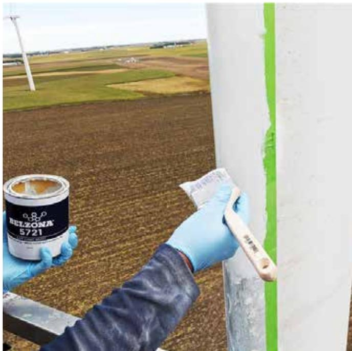
Belzona 5721 é um revestimento de alto desempenho bicomponente, formulado especificamente para proteção de bordas de ataque de pás de aerogeradores contra erosão e danos por impacto.
