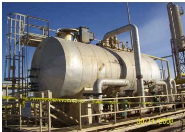
Belzona 5892 usado para alinhar um dessalinizador
