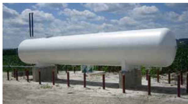
Aplicação concluída, usando Belzona 5111 para maior proteção
