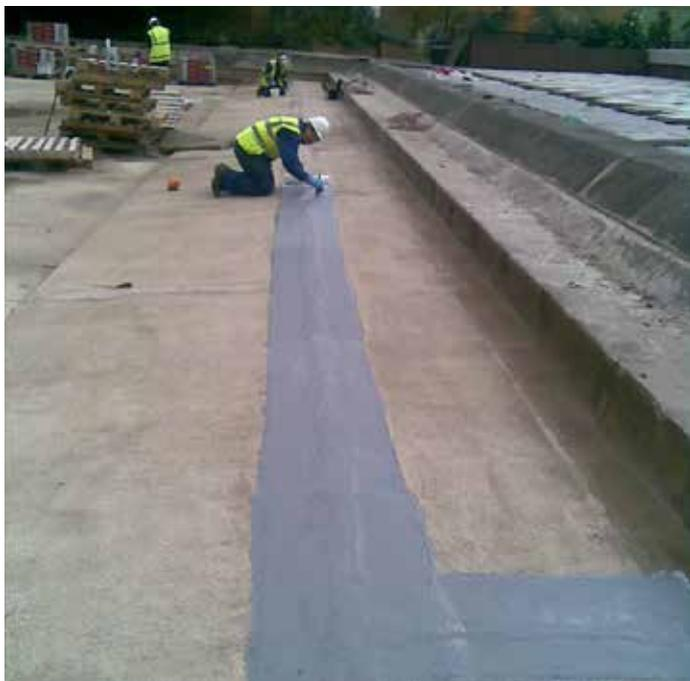
Belzona 3121 (MR7) é um sistema bicomponente para reparos de emergência e proteção contra intempéries, que veda quase todos os tipos de superfícies e estruturas de telhados, mesmo durante condições meteorológicas adversas. Este material, aplicado sob a forma líquida, foi desenvolvido para a impermeabilização instantânea e pode ser aplicado em qualquer condição climática ao longo do ano.
