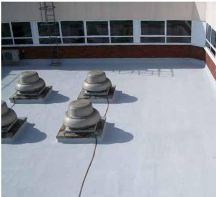
Belzona 3111 (Flexible Membrane) é um revestimento microporoso de componente único, isento de solventes, para reparo e proteção duradoura de todos os tipos de telhados, bases de tanques e outras estruturas.
