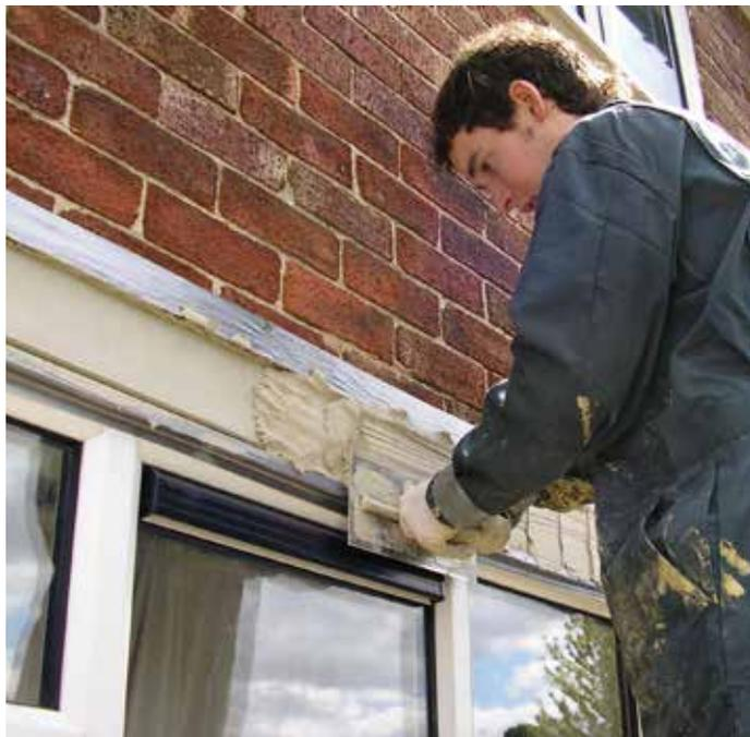
Belzona 4141 (Magma-Build) é um compósito de reparo leve, bicomponente, para restauração de superfícies verticais e suspensas de concreto danificadas. Este sistema de grande espessura simplifica a aplicação, ao mesmo tempo em que oferece proteção duradoura.
